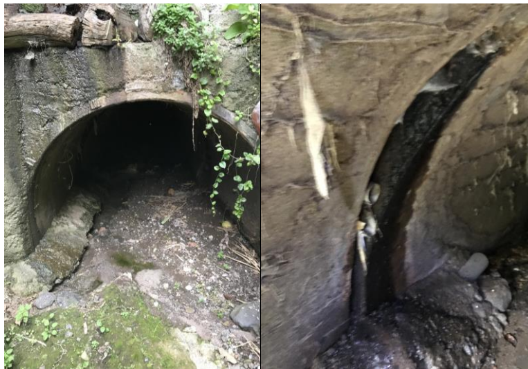
Figura 9. Vista de vertidos de aguas residuales en la bocamina de entrada
