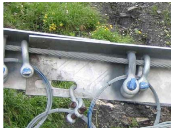
Fijación para evitar la torsión de la pieza
