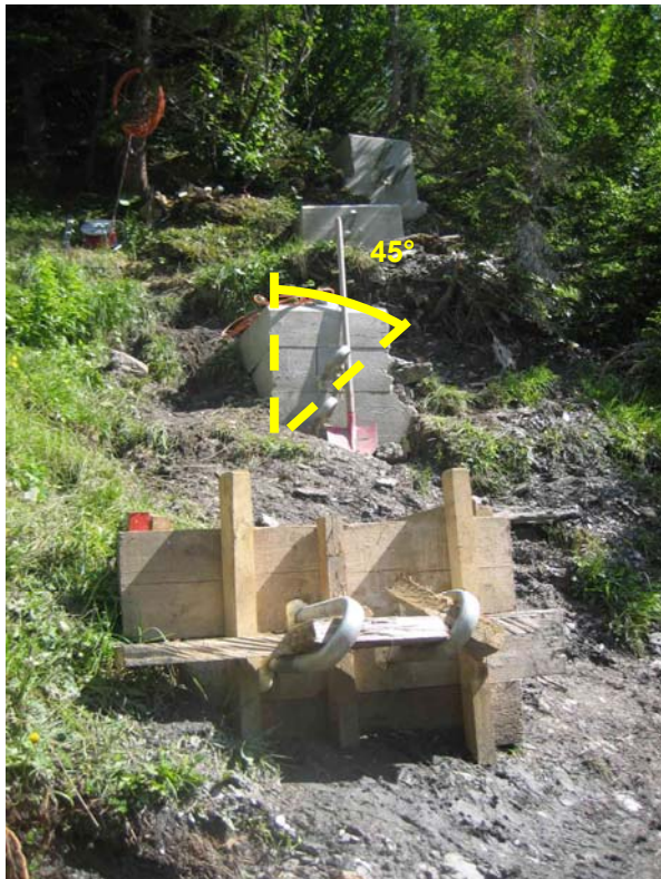
Disposición correcta de las cabezas de los anclajes flexibles.
