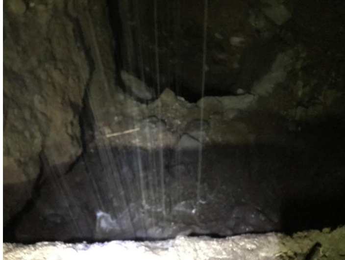
Figura 10. Vista de vertidos de techo en el PK 0+027,5
