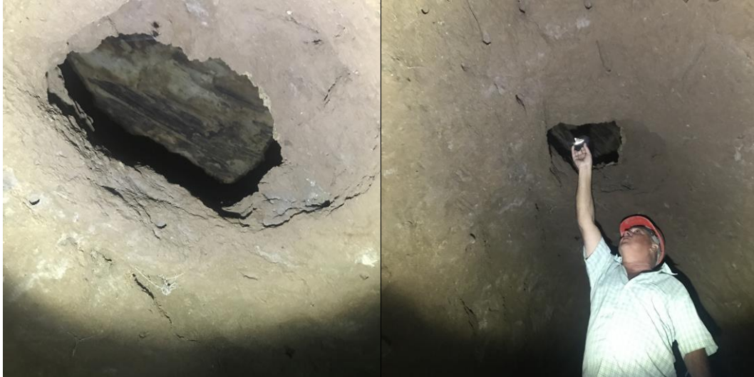
Figura 8. Vista de tubo volcánico en la clave
